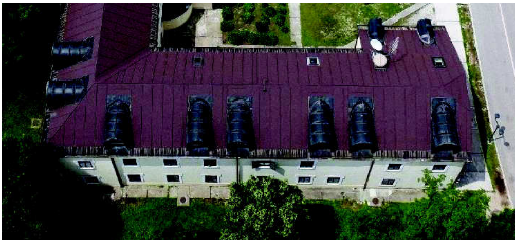
F1 - F2 Faadni otvori sa južne strane objekta ↑ ↓
