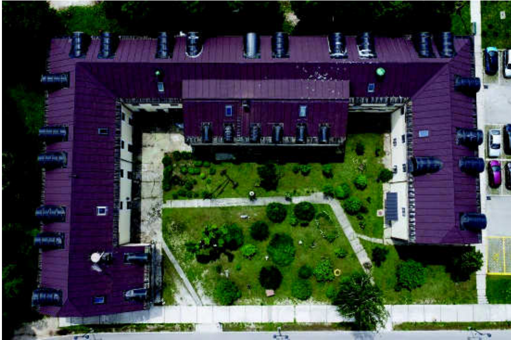
F12 - F13 - F14 Krovni prozori - manje krovne kućice - pozicija 2 - komada 8 ↑ ↓
